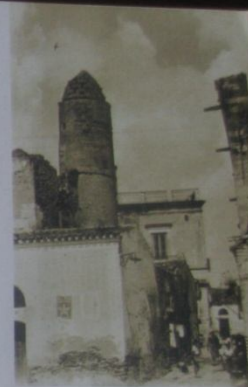
Ortona Anni Cinquanta. La massiccia torretta circolare, con sovrastante colombaio, costruita nella seconda metà del Settecento a completamento di una struttura difensiva già esistente dalla prima metà dello stesso secolo. Posta in posizione strategica all'incrocio delle strade per Orta Nova, Napoli e Foggia, è stata abbattuta nel 1974.
